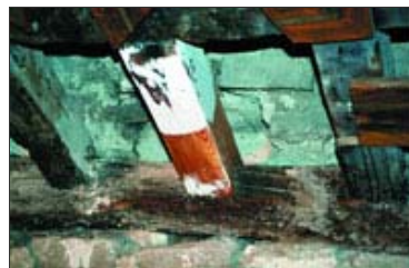
Foto 23 Para deteriorado y consolidado
