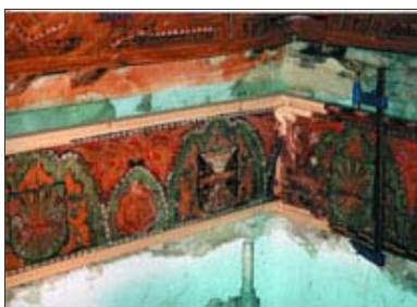
Foto 35: Arrocabe lado este con tocaduras nuevas
