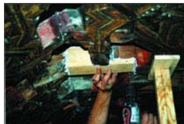
Foto 25 Sustitución de nudillo deteriorado
