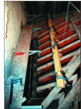
Foto 33: Arriostamiento de las alfardas previo a la operación de sustitución
