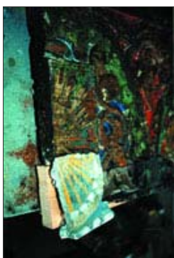
Foto 28 Reposiciones de escayola en zonas con pérdida de soporte
