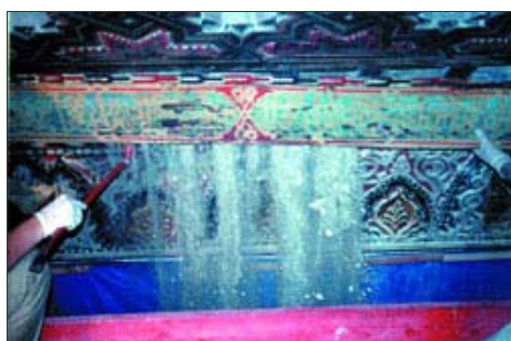
Foto 30 Desmontaje de la cornisa
