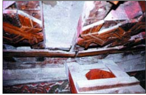
Foto 20 Unión entre estribos longitudinales 1 y 2
