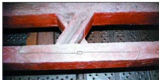
Foto 15: Empalme en tirante
