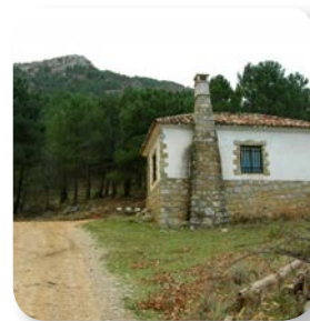
Control de acceso a la pista forestal del Chorro
